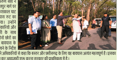
उप मुख्यमंत्री तथा लोक निर्माण मंत्री अरुण साव ने रायपुर-जादपुर मार्ग पर बहुमतीकित केशकाल घाट परियोजना का निरीक्षण किया। उन्होंने विभागीय अधिकारियों और निगम एजेंसी के साथ बायास के दोनों छोटों का निरीक्षण कर बायास के काम में तेजी लाने के निर्देश दिए। श्री साव ने अधिकारियों से कहा कि बस्तर और छत्तीसगढ़ के लिए यह बायास अत्यंत महत्वपूर्ण है। इसका तेजी से निर्माण कर आवागामी शुरू करना सरकार की प्राथमिकता है।
