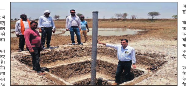
परकुलेशन टैंक का निर्माण भी कराया जा रहा है, जिससे जल संचयन एवं जल रिचार्ज की प्रक्रिया को और अधिक प्राथमिकता के साथ क्रियान्वित किया जा रहा है, ताकि
