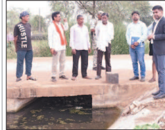
कलेक्टर जितेन्द्र यादव ने अर्था जलाशय एवं बोटेपार जलाशय से निरीक्षण वाली निर्माणधीन पक्की नहर लाइनिंग का निरीक्षण किया।
